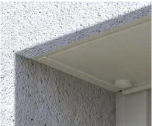
Prinzipdarstellung Friesaussparung
