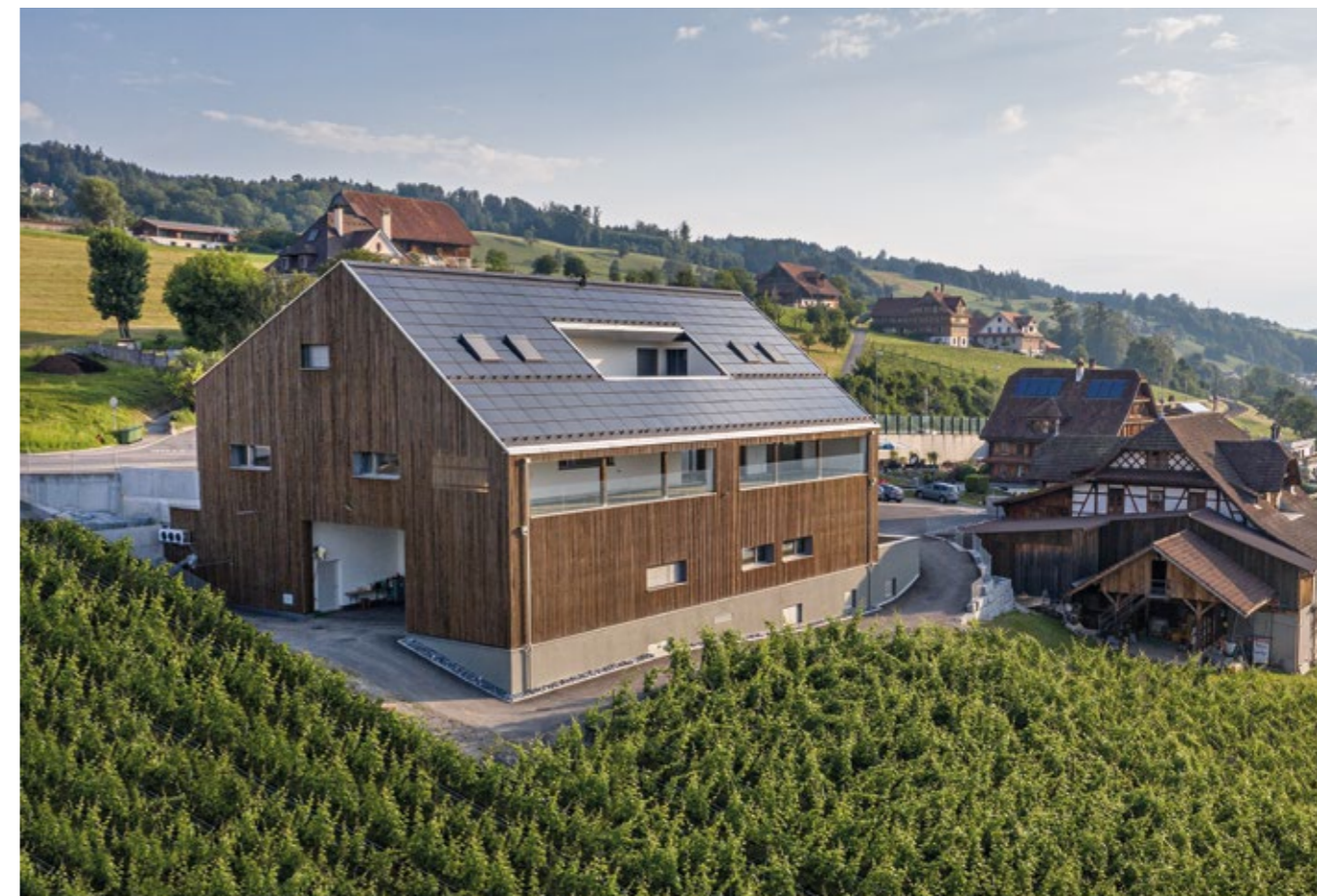
Weingut Letten, Meggen, Schweiz. Architekt: Lötscher Architektur GmbH, Meggen, Schweiz. Fotograf: Meraner & Hauser OHG/SNC, Bozen, Italien.
