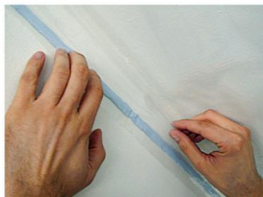
2. Entlastungsschlaufe in Dampfsperre legen, da diese Baubewegungen aufnimmt.
