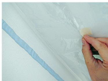
1. Dampfsperre mit Klebeband fixieren. 8 mm dicke OTTOCOLL® A270-Raue auftragen und 1 - 3 Tage ruhen lassen.
