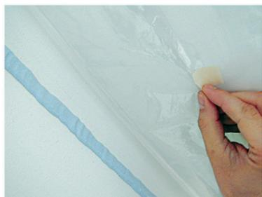
1. Dampfsperre mit Klebeband fixieren. Unmittelbar nach dem Auftragen der **8 mm dicken OTTOCOLL® A270-Raue** die fixierte Dampfsperre lösen.
