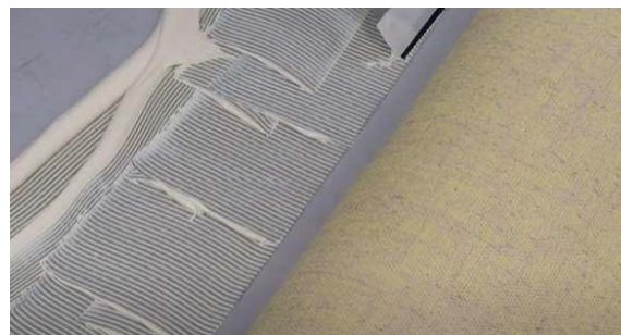
Klebstoffauftrag B1 Zahnung (TKB Ausführung, ca. 300 – 350 g/m 2 bei Belägen mit Juterücken)
