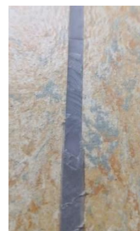
Die Verwendung von ungeschliffenen Klingen führt zu einem schlechten optischen Erscheinungsbild, und einer verstärkten Verschmutzung im Verlauf der Nutzung.
