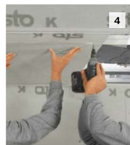
Montage der StoCarrier Aero wie auf Seite 20 im Kapitel „Montage Trägerplatten“ beschrieben.
