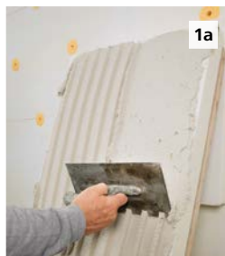
Sto-Dämmplatte PIR BLF-S aus Polyisocyanurat-Hartschaum nach DIN EN 13162 Format: 100x50 cm
