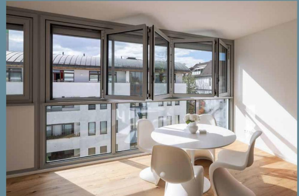
Neben der energetischen Optimierung sollte der Freiluftcharakter der Loggien des 50er-Jahre-Bestandsgebäudes erhalten bleiben. Mit dem wärmegeämmten Fassadenmodul wurde die passende Lösung gefunden. Auf Wunsch des Bauherren übernahm Solarlux die gesamte Abwicklung der Fassadensanierung - von der Projektleitung und Detailplanung über das Aufmaß bis hin zur Ausführung und Abnahme.
