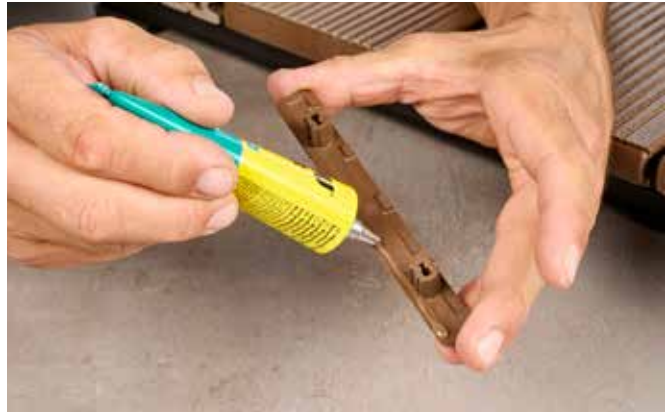
1. Kleber auf obere Kantenseite anbringen
