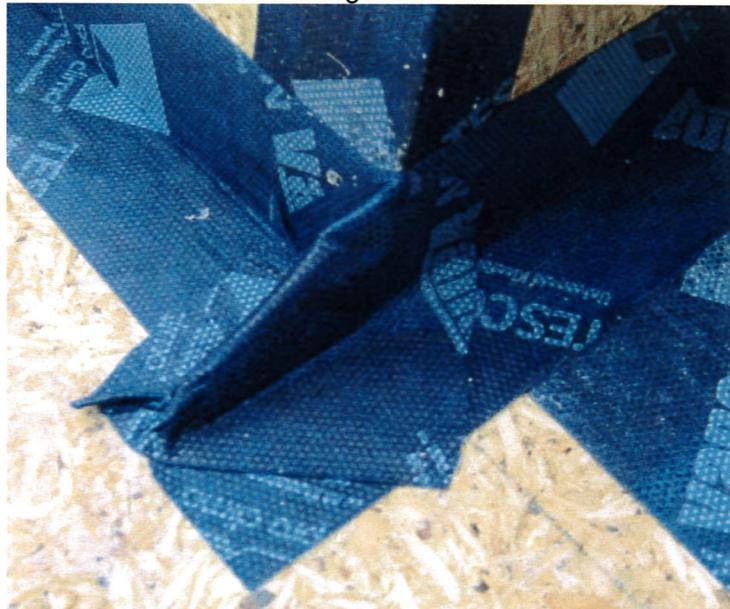
Abbildung 3: Ausbildung der Ecklösung zur Abdichtung der Kamindurchdringung mit dem Systemklebeband
