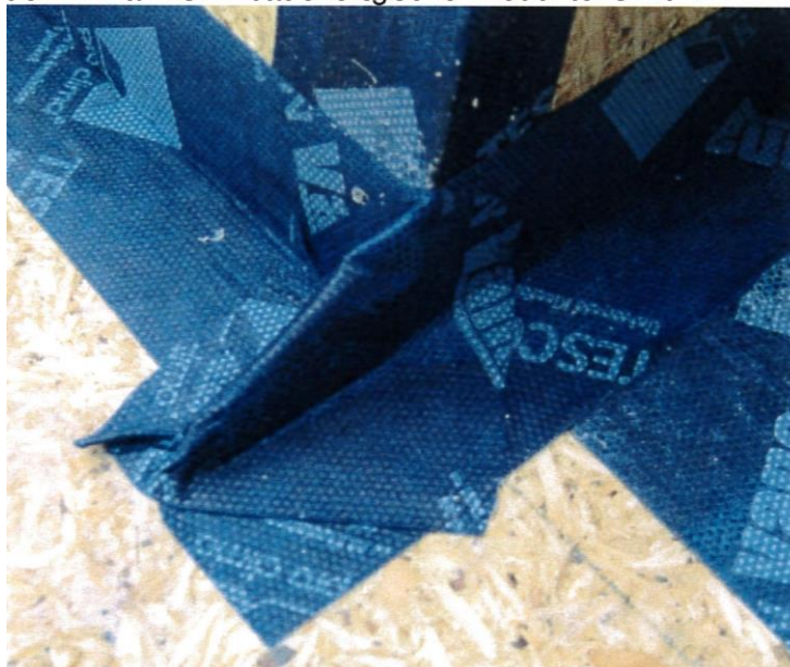
Abbildung 3: Ausbildung der Ecklösung zur Abdichtung der Kamindurchdringung mit dem Systemklebeband
