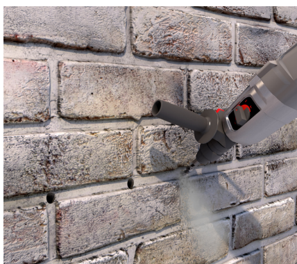
1. Bohren und anschließend Bohrloch ausblasen.
