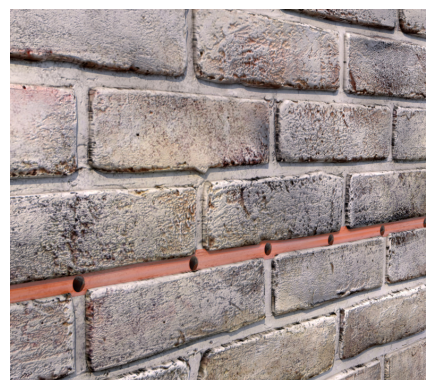
3. Verfilmte Horizontalsperre aus PCI Barra Creme.
