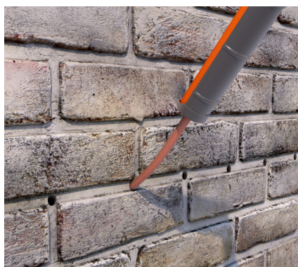
2. PCI Barra Creme von innen nach außen injizieren.
