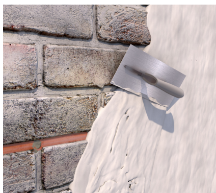
5. Überarbeiten des Mauerwerks mit PCI Saniment 2 in 1.
