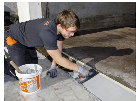
Mit PCI Aposan können selbst stark beanspruchte Garagenschwellen dauerhaft repariert werden.
