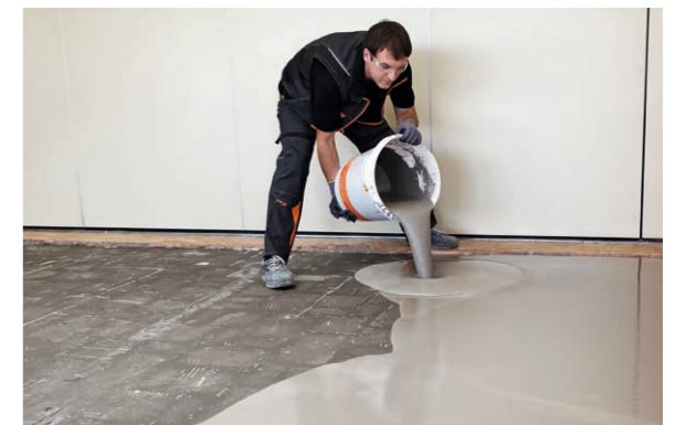
Mit PCI Periplan Multi lässt sich ein schnell begehr- und belastbarer Bodenausgleich einfach herstellen.
