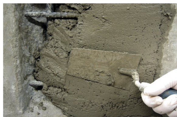
SikaQuick-506 FG überzeugt mit einer einfachen Verarbeitung ohne Haftbrücke in einem Arbeitsgang.
