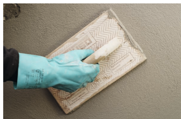
Schnelles Ausbessern von Ausbrüchen – nur eine der vielen Einsatzmöglichkeiten des universellen Reparaturmörtels PCI Nanocret R2.
