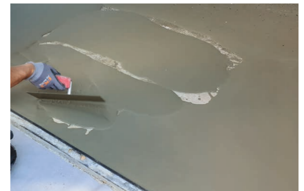
Trotz flüssiger Konsistenz lässt sich PCI Zemtec Outdoor ganz einfach und ohne Nachsacken an Abflüsse und Kanten anarbeiten, selbst auf Gefälle.
