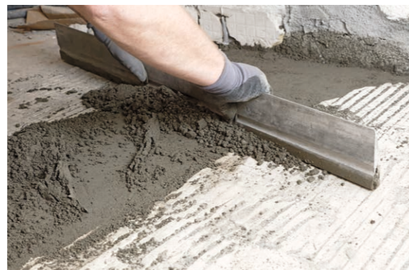
Die Konsistenz von PCI Repament Multi lässt sich über die Wassermenge variabel einstellen – von fließfähig bis standfest.
