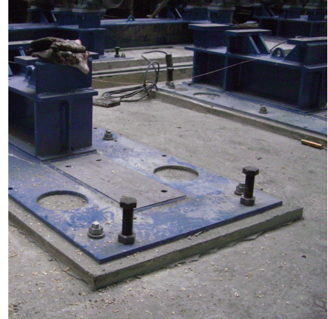
PCI Repaflow schafft eine nahtlose, risse- und hohlraumfreie Verbindung, die einen ruhigen Maschinenverlauf und dadurch präziseres Arbeiten und geringeren Maschinenverschleiß bewirkt.
