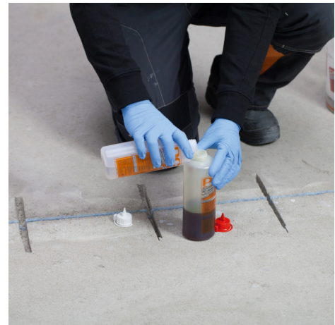
PCI Apogel ® SH kann einfach nach Mischen in der Flasche angewendet werden.
