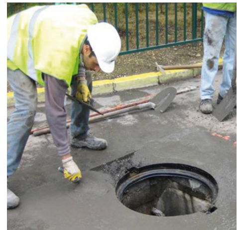
Einbetten eines Schachtringes mit PCI Repafast Tixo
