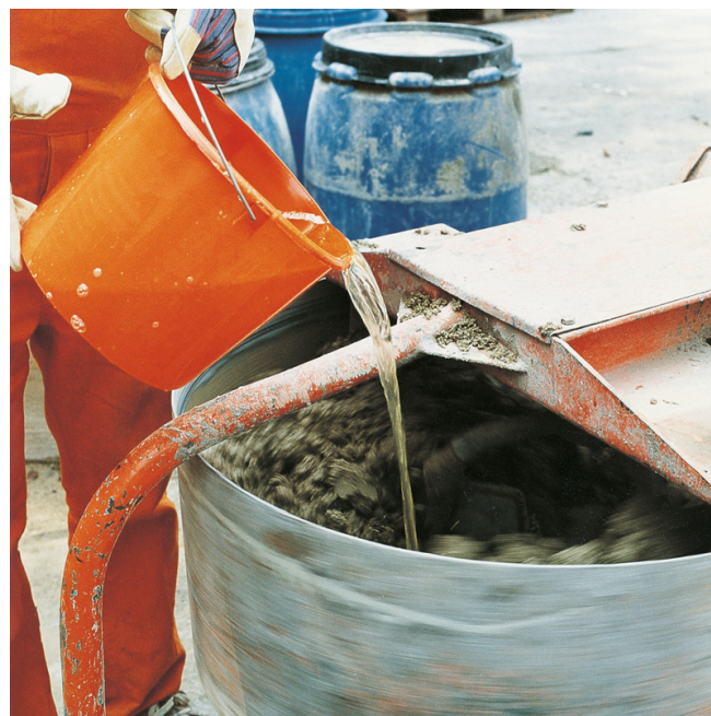
Das mit PCI Mischöl vermischte Anmachwasser wird dem Mörtel zugegeben.
