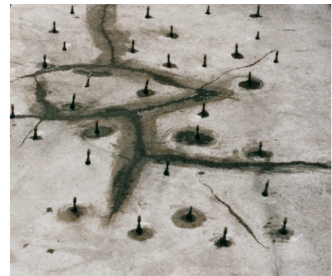
Risse vergießen und hohlliegenden Estrich verpressen mit PCI Apogel F.
