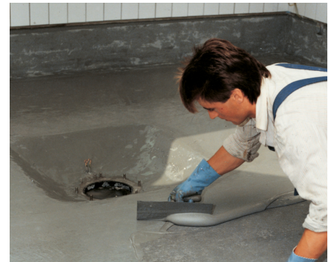
Auftragen von PCI Apoflex F zum Abdichten unter dem Keramikbelag einer Großküche.
