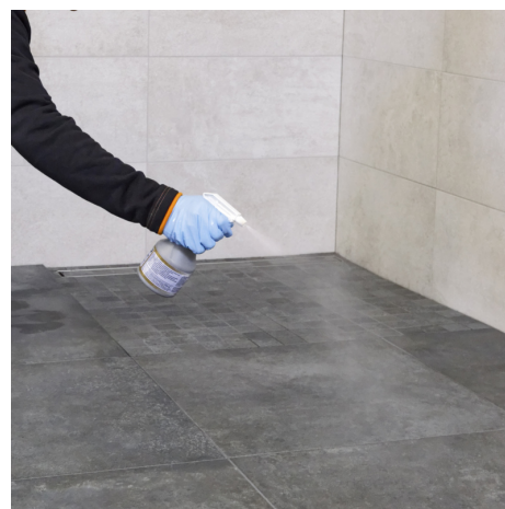
Alternativ PCI Durapox Finish (Flüssig) vor dem finalen Waschgang aufsprühen.
