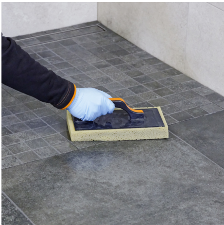
Finaler Waschgang: Abreinigen der Fläche mit dem Schwammbrett
