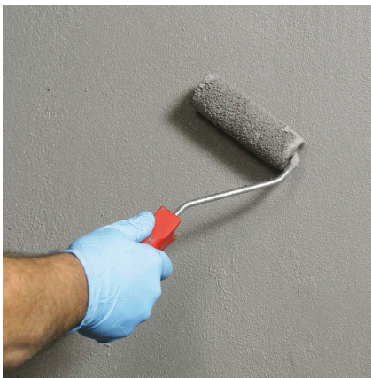
1. Auftrag im Streichverfahren mit z. B. einer Rolle oder Flächenstreicher volldeckend aufbringen.
