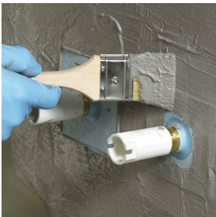
Die Dichtmanschetten PCI Pecitape 10 x 10 ordnungsgemäß einbetten.
