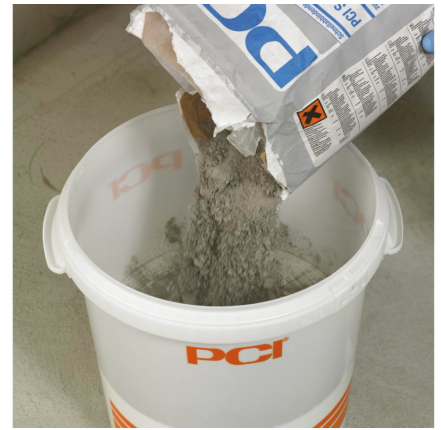
PCI Seccoral 2K Rapid Pulver dazugeben.
