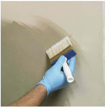
Untergrund mattfeucht vorbereiten.
