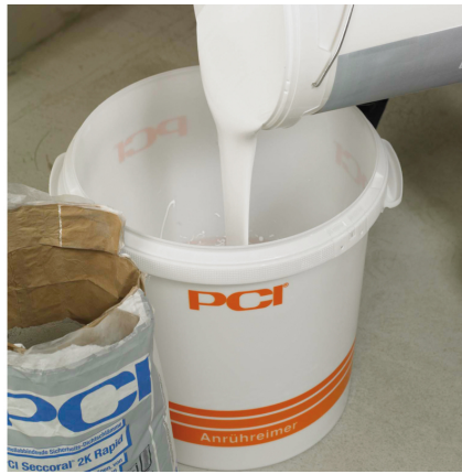
PCI Seccoral 2K Rapid flüssig in ein sauberes Mischgefäß geben.
