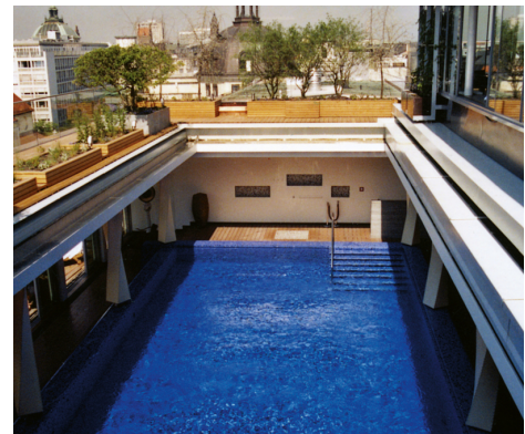
Mit PCI Collastic verlegte Fliesen in einem Schwimmbecken.
