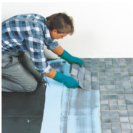
Fliesen oder Platten werden im aufgekämmten Kleberbett angesetzt und ausgerichtet.
