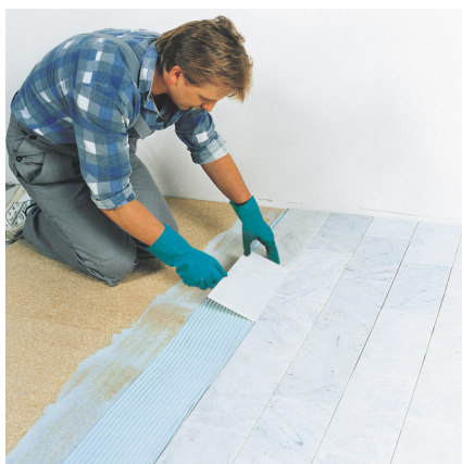
Mit dem Reaktionsharz-Fliesenkleber PCI Collastic kann auch Marmor auf Holzspanplatten verlegt werden.
