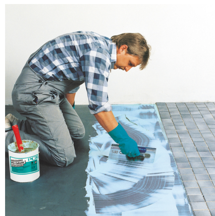
Auch Stahlbleche eignen sich in Verbindung mit PCI Collastic als Verlegeuntergrund.
