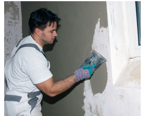
PCI Pericret lässt sich sehr geschmeidig verarbeiten - in Schichtdicken von 3 bis 50 mm.
