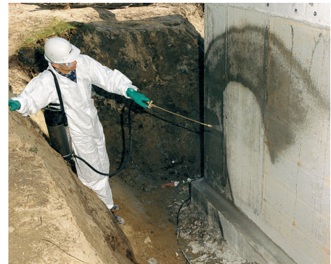
Blasenfreie Abdichtung mit Bitumen-Dickbeschichtungen auf Betonaußenwänden nach der Grundierung mit PCI Pecimor-Betongrund.
