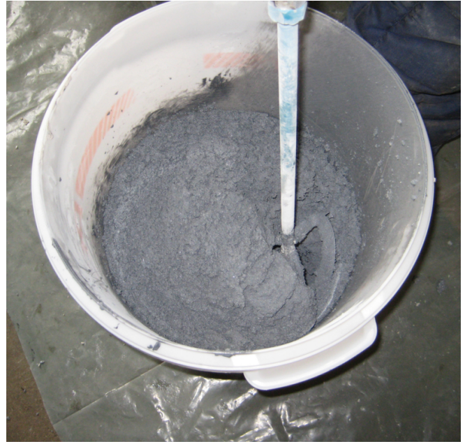
Gemischtes Material "umtopfen", um Mischfehler in Gebinderandbereichen zu vermeiden. Wenn notwendig nachmischen.
