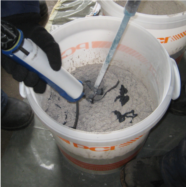
Dann Komponente B zu der Masse geben und nochmals mindestens 2 Minuten mischen.
