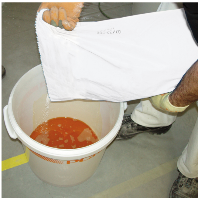
Den Sack von Komponente C aus dem Eimer entnehmen. Den Inhalt von Komponente A in den Eimer gießen und die Komponente C hinzufügen.
