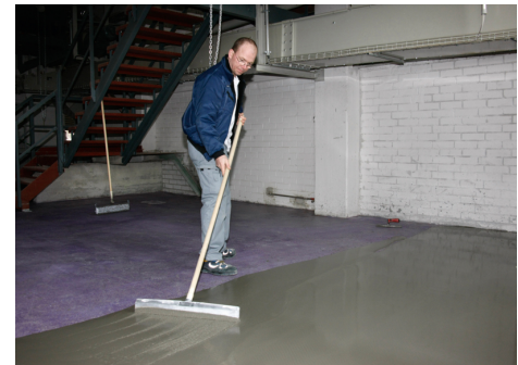
Mit PCI Periplan® Multi lässt sich ein schnell belastbarer Bodenausgleich einfach herstellen
