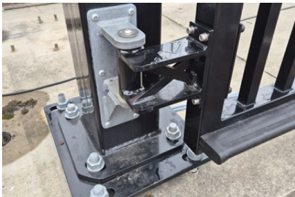
Pfosten auf Fußplatte
