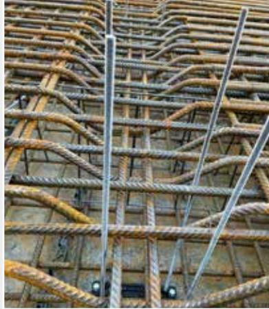
*Bewehrung einbauen. Gewindestangen montieren.*
