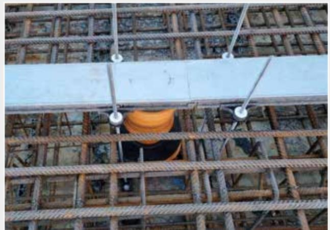
*Sicherungen anbringen und Gewindestangen kürzen. Montageabdeckblech anbringen.*
