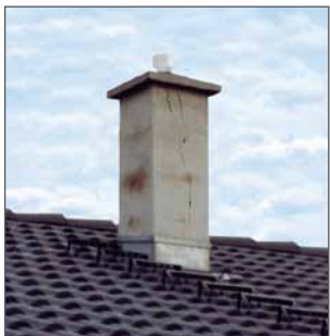
Bis außen durchgehende Risse im Schornstein.
