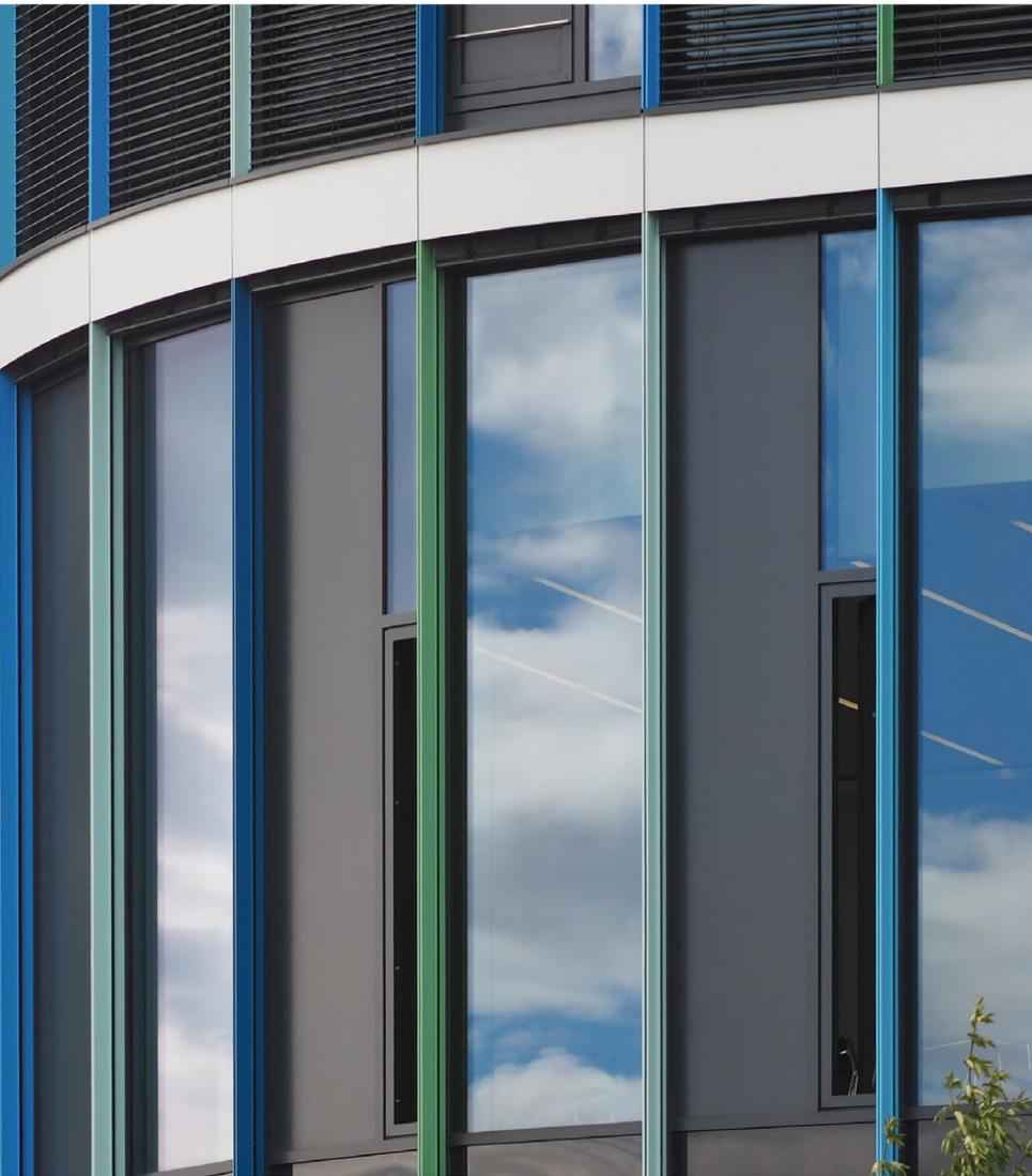
Vor allem die extrem schmalen bodentiefen Blockfenster mit den verdeckten Beschlägen stellten ganz besondere Ansprüche an die Sonderkonstruktion.
