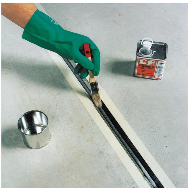
Vor dem Verfugen die gereinigten Fugenflanken mit PCI Elastoprimer Uni mit einem Pinsel grundieren. Nach dem Ablüften ...
