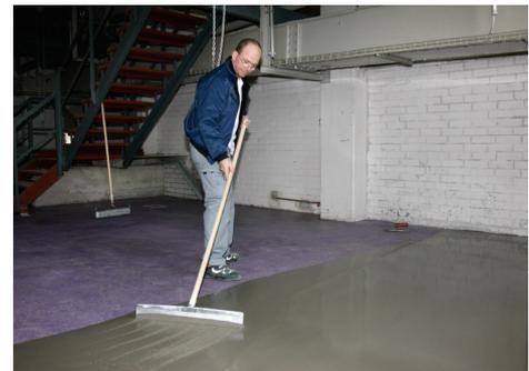
Mit PCI Zemtec<sup>®</sup> 180 lässt sich ein schnell belastbarer Bodenausgleich einfach herstellen
