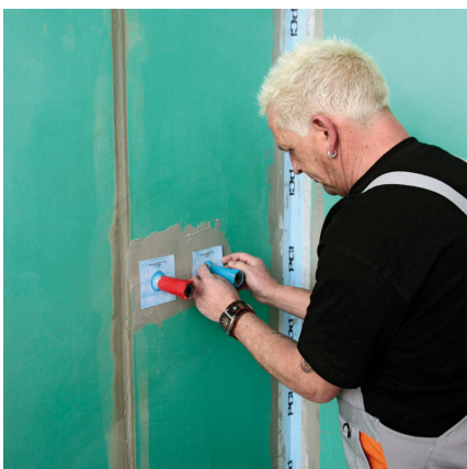
...nachfolgend die Dichtmanschette vorsichtig über den Stopfen, auf das Verlängerungsstück gezogen und in die frische Abdichtung einbetten.
