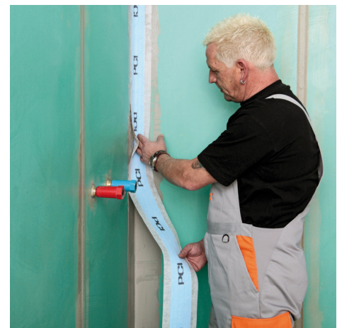
PCI Pecitape wird in die frische Auftragschicht des verwendeten Abdichtungsmaterials eingebettet.
