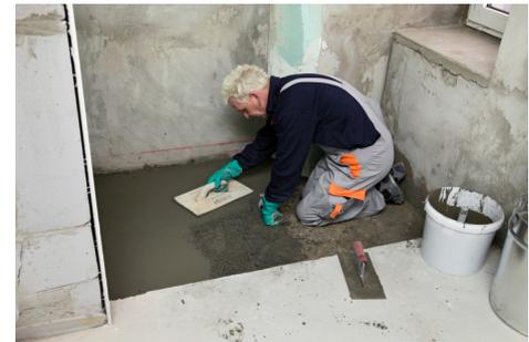
PCI Novoment M1 plus ist ein Schnellestrich-Fertigmörtel und daher eine wirtschaftliche und besonders praktische Lösung für den Einbau von kleineren Flächen und Estrich-Teilflächen, die schnell genutzt werden müssen.
