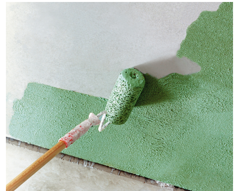
An der griffigen Gipsputz-Haftbrücke PCI Gisopakt kann sich später der Deckenputz fest verankern.
