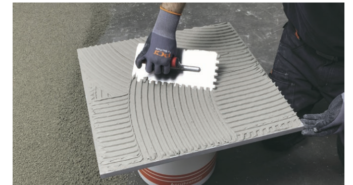
PCI Carrament oder PCI Flexmörtel S1 Flott als Haftbrücke aufbringen ...
