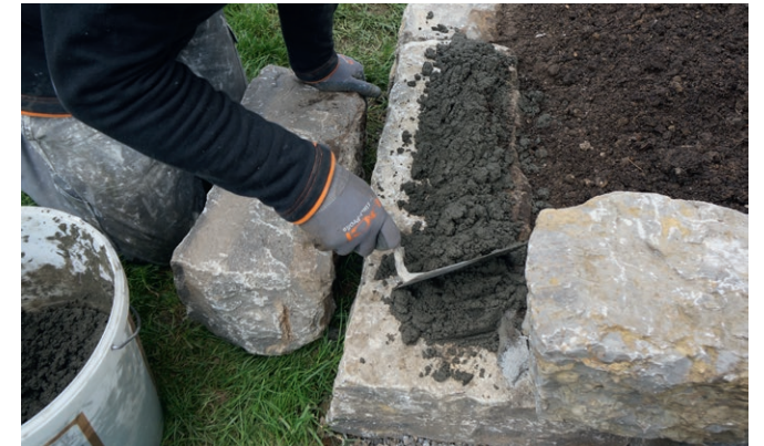
PCI Carraroc kann in Mörtelbettdicken von 5 bis 40 mm eingesetzt werden.
