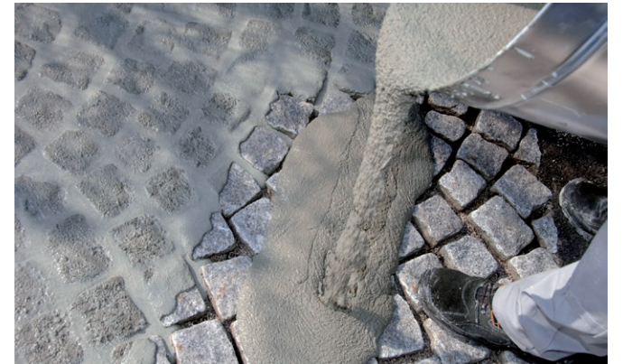
Den fließfähigen PCI Pavifix CEM homogen anmischen ...
