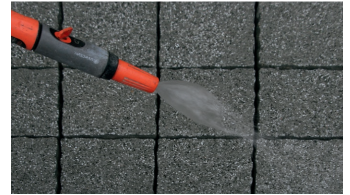
Vor der Verarbeitung mit PCI Pavifix 1K Extra Flächen satt vornässen.
