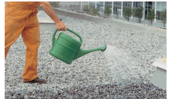
Verfestigung einer Kiesschüttung mit PCI Stabiflex.
