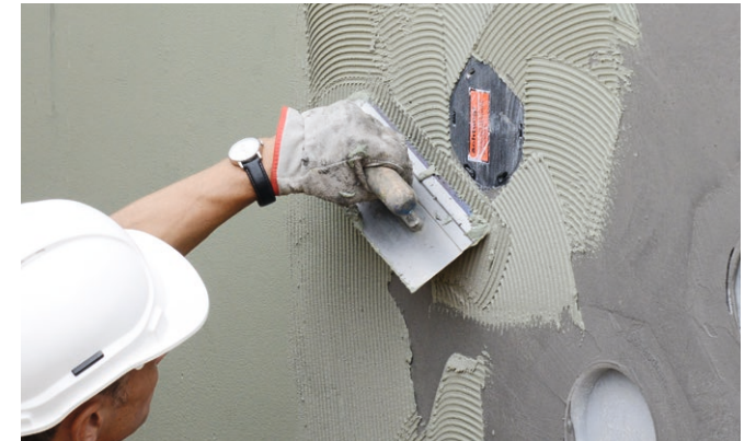
Aufbringen der UV-beständigen Sockelabdichtung PCI Barraseal Turbo im Spachtelverfahren.
