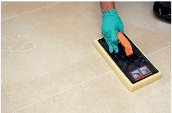
Die sehr feine Mörtelstruktur und die besondere Flankenhaftung zeichnen PCI Nanofug Premium aus – auch bei sehr schmalen Fugen.
