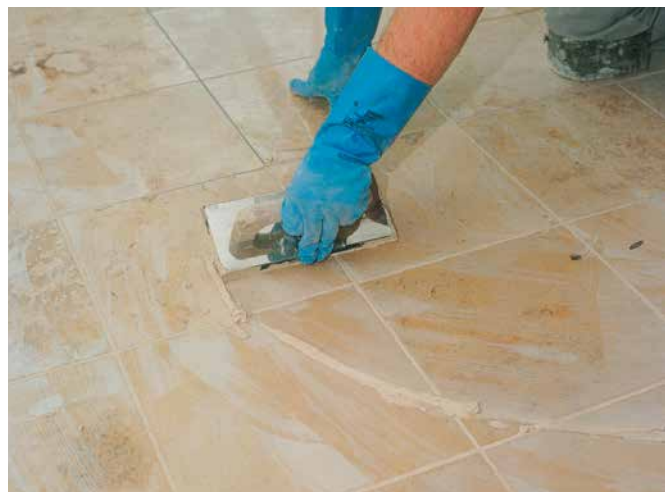
Verfugen mit schnell abbindendem Fugenmörtel
