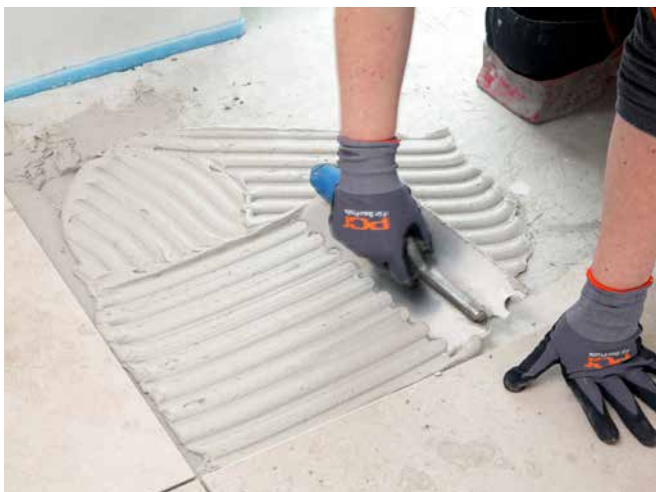
Verlegen Naturwerksteinbeläge auf Abdichtung
