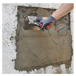
Der schnelle Reparaturmörtel PCI Nanocret R4 Rapid ist sofort modellierbar und trocknet auch bei Temperaturen ab 1 °C aus.
