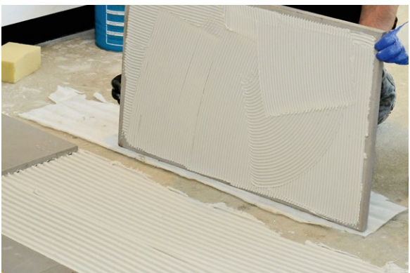
PCI Carraflex – zum sicheren Verlegen von hellen Naturwerksteinen und weißem Marmor im Buttering-Floating-Verfahren.
