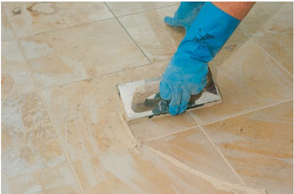
Mit PCI Carrafug lassen sich auch empfindliche Naturwerksteinbeläge sicher und verfärbungsfrei verfugen.
