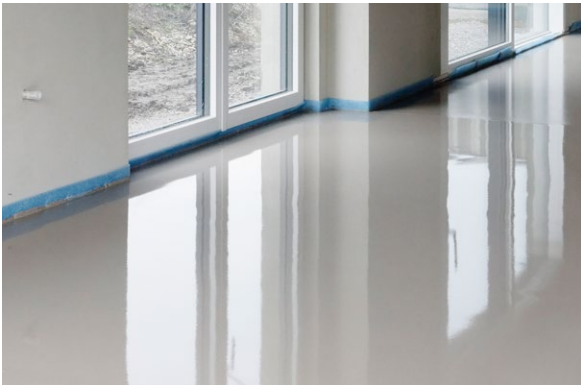
Entspanntes Arbeiten: Anrühren – Ausgießen – Läuft!
