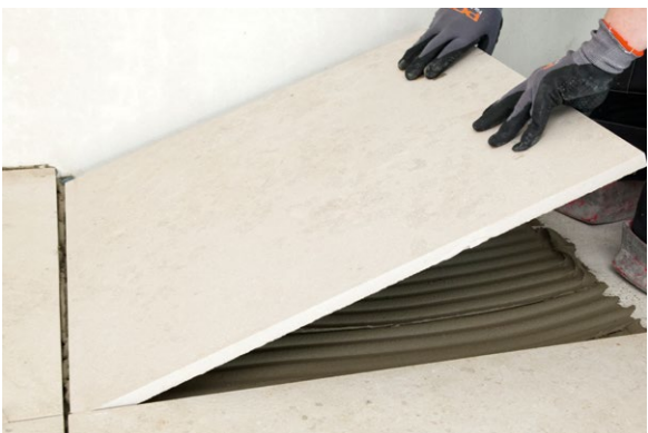
Mit PCI Carrament können Naturwerksteinbeläge sicher im Mittelbettverfahren verlegt werden.
