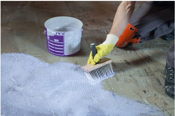
PCI Gisogrund 404 in der Kontrollfarbe Violett ermöglicht eine hohe Verbundhaftfestigkeit von Ausgleichsmassen und Verlegewerkstoffen zum jeweiligen Untergrund.
