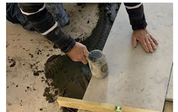
Mit PCI Carraroc lassen sich im Dickbettverfahren Platten und Mauersteine in unterschiedlicher Größe und Stärke verlegen.
