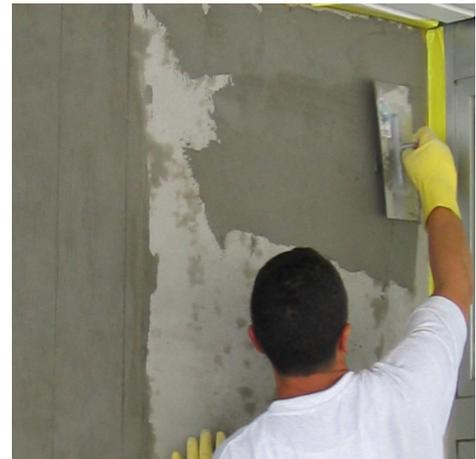
PCI Barrafill L für Kosmetikarbeiten an Betonbauteilen.
