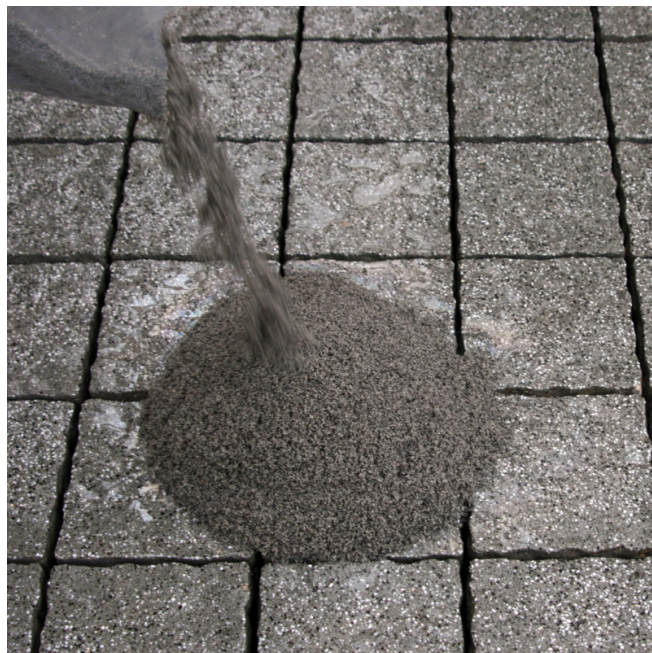
Vakuumbeutel aufschneiden und frisches Material auf die nasse Belags- oberfläche schütten.
