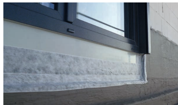
Anschluss Fensterelement mit Fixband PCI Pecithene Fix
