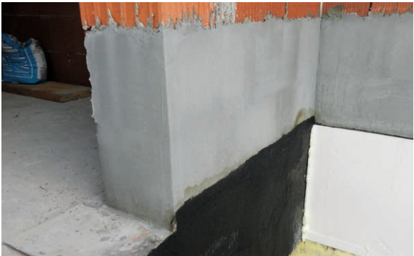
Zwischenabdichtung mit PCI Barraseal
