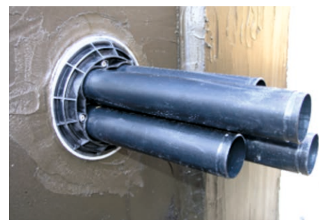
Anarbeiten von PCI Barraseal Turbo oder PCI Barraseal Turbo 1K an eine Mehrspartenhauseinführung
