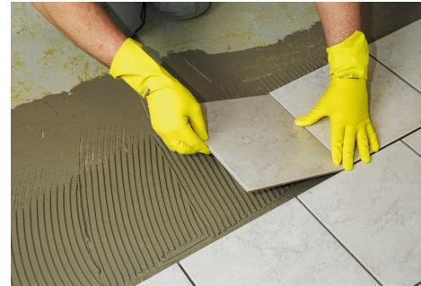
Mit PCI FT Rapid können keramische Fliesen sicher verlegt werden und sind schnell begehbar und verfügbar.
