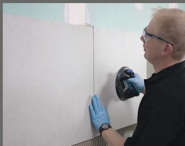
PCI Flexmörtel® S1 ist komfortabel beim Aufziehen und besonders standfest auch bei großformatigen Feinsteinzeugfliesen an der Wand.
