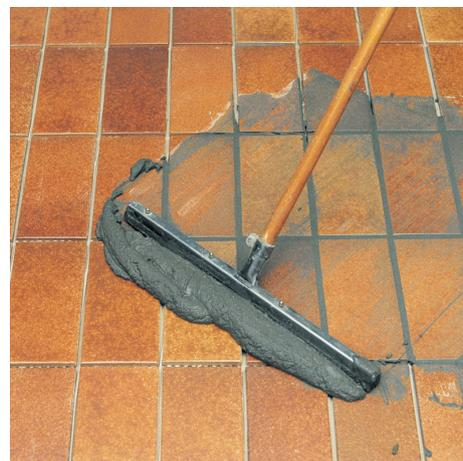
PCI FT Fugenbreit bündig in die Fugen einbringen. Oberfläche sauber abziehen ...
