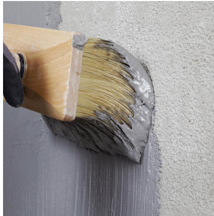
Aufbringen einer Kontaktschicht mittels Bürste oder Quast.
