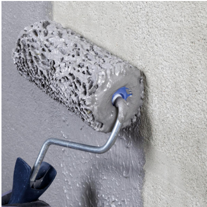
Aufbringen einer Kontaktschicht mit dem Roller.
