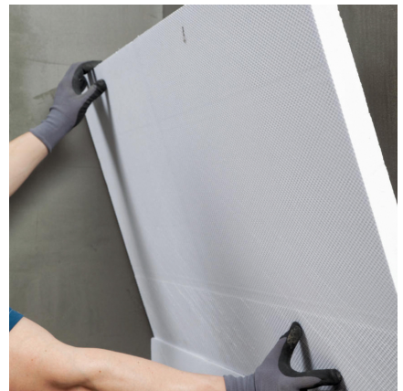
Drain- und Dämmplatten können auf die erhärtete Abdichtung mit PCI Barraseal Turbo 1K geklebt werden.
