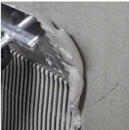
PCI Barraseal Turbo 1K muss in mindestens 2 Abdichtungslagen aufgebracht werden. Zur Kontrolle der Schichtdicke kann das Material aufgezahnt und dann abgeglättet werden.
