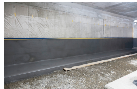
PCI Barraseal Turbo 1K als Oberflächenschutzsystem in einer Tiefgarage.
