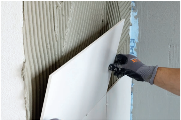
Mit PCI FT Extra können Steingutfliesen auf der alternativen Abdichtung PCI Lastogum sicher verlegt werden.
