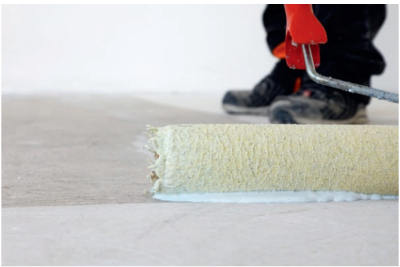
Dank der blauen Kontrollfarbe ermöglicht PCI Gisogrund einen exakten Flächenauftrag.
