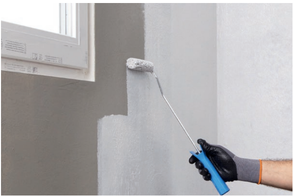
PCI Lastogum wird 2-lagig durch Rollen, Streichen oder Spachteln auf den Untergrund aufgebracht.
