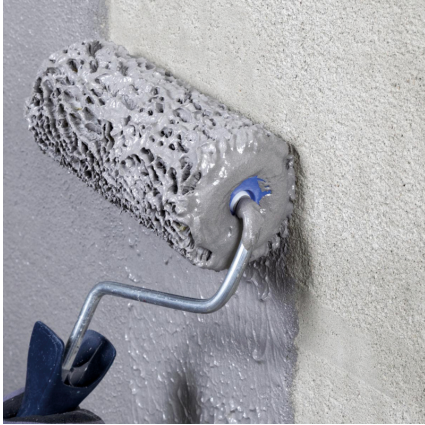
Aufbringen einer Kontaktschicht mit dem Roller.
