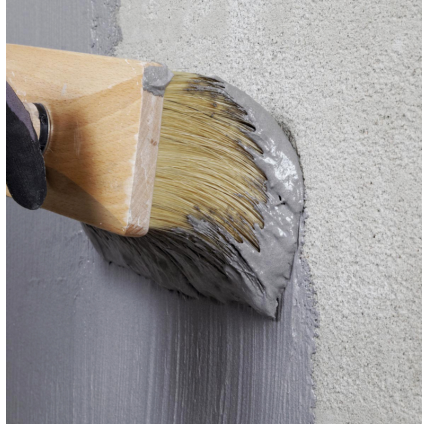
Aufbringen einer Kontaktschicht mittels Bürste oder Quast.
