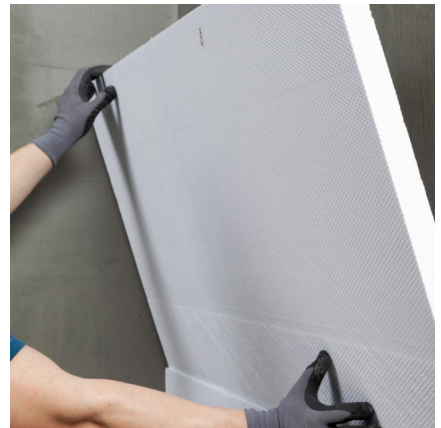
Drain- und Dämmplatten können auf die erhärtete Abdichtung mit PCI Barraseal Turbo geklebt werden.
