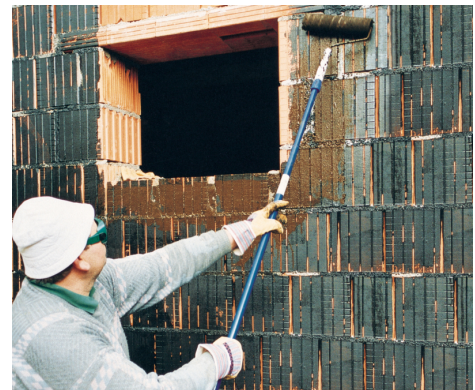
PCI Pecimor F, 1 : 5 mit Wasser verdünnt, als Grundierung für eine Bauwerksabdichtung mit kunststoffmodifizierter Bitumendickbeschichtung nach DIN 18 533.
